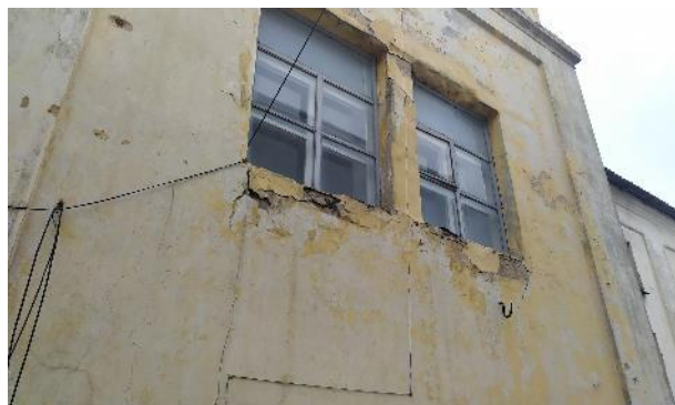
Фотография 10. Фасад здания, в котором расположен объект оценки
