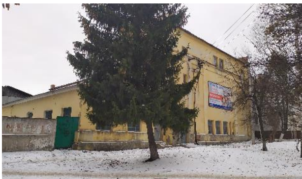
Фотография 17. Фасад здания, в котором расположен объект оценки
