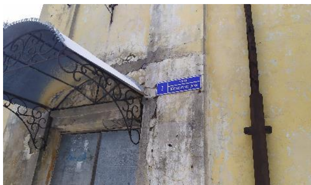
Фотография 11. Фасад здания, в котором расположен объект оценки
