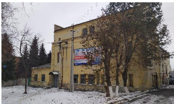
Фотография 8. Фасад здания, в котором расположен объект оценки
