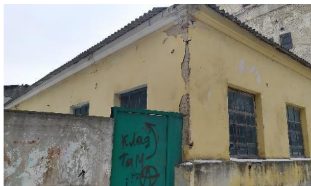
Фотография 14. Фасад здания, в котором расположен объект оценки
