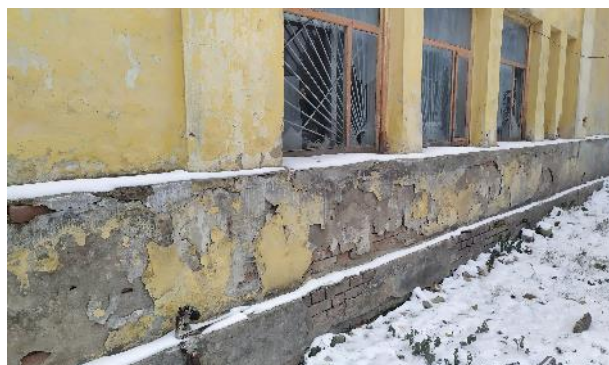
Фотография 12. Фасад здания, в котором расположен объект оценки
