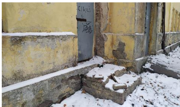
Фотография 13. Фасад здания, в котором расположен объект оценки
