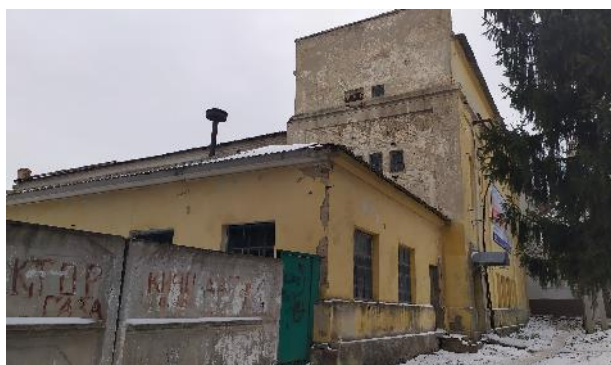
Фотография 15. Фасад здания, в котором расположен объект оценки
