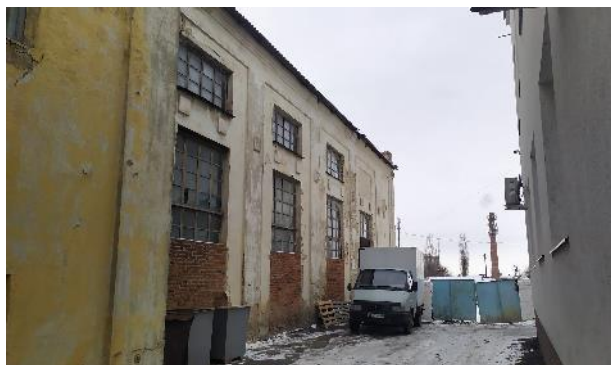
Фотография 9. Фасад здания, в котором расположен объект оценки
